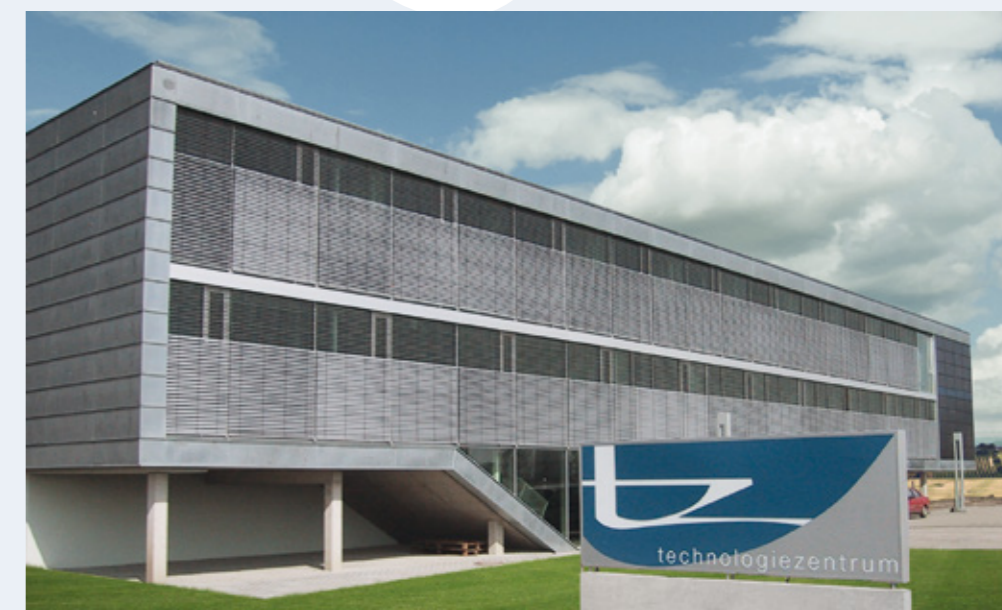
Glas und Beton geben an der Fassade des Technologiezentrums Perg den Ton an.
