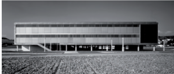
Glas und Beton geben an der Fassade des Technologiezentrums Perg den Ton an
